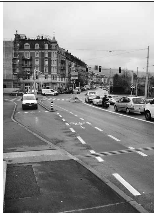
Die neuen Markierungen auf der Duttweilerbrücke.
